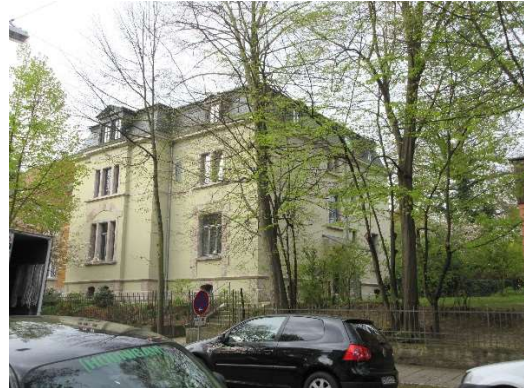
Abb. 5: nach Renovierung im März 2017
